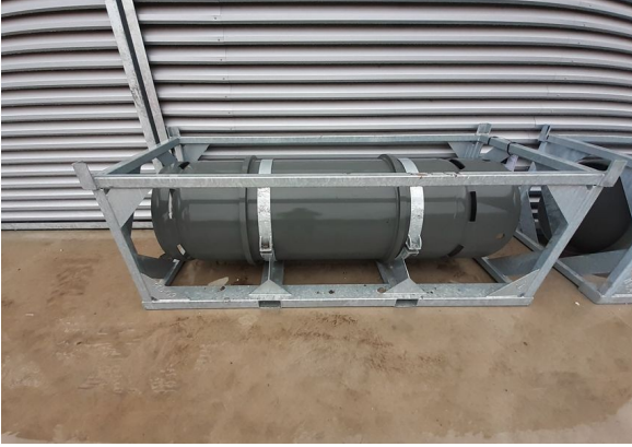
Réservoirs de stockage de fluide frigorigènes
